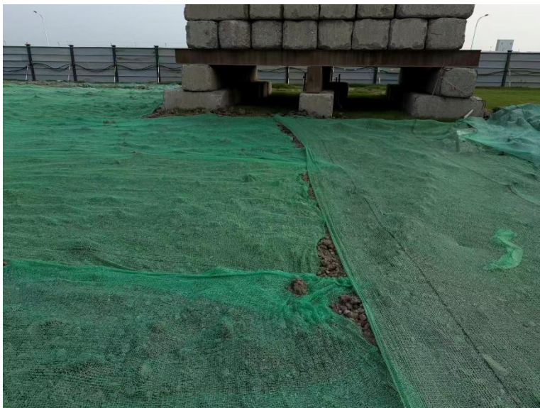
图4-2新建建筑物区密目网苫盖
