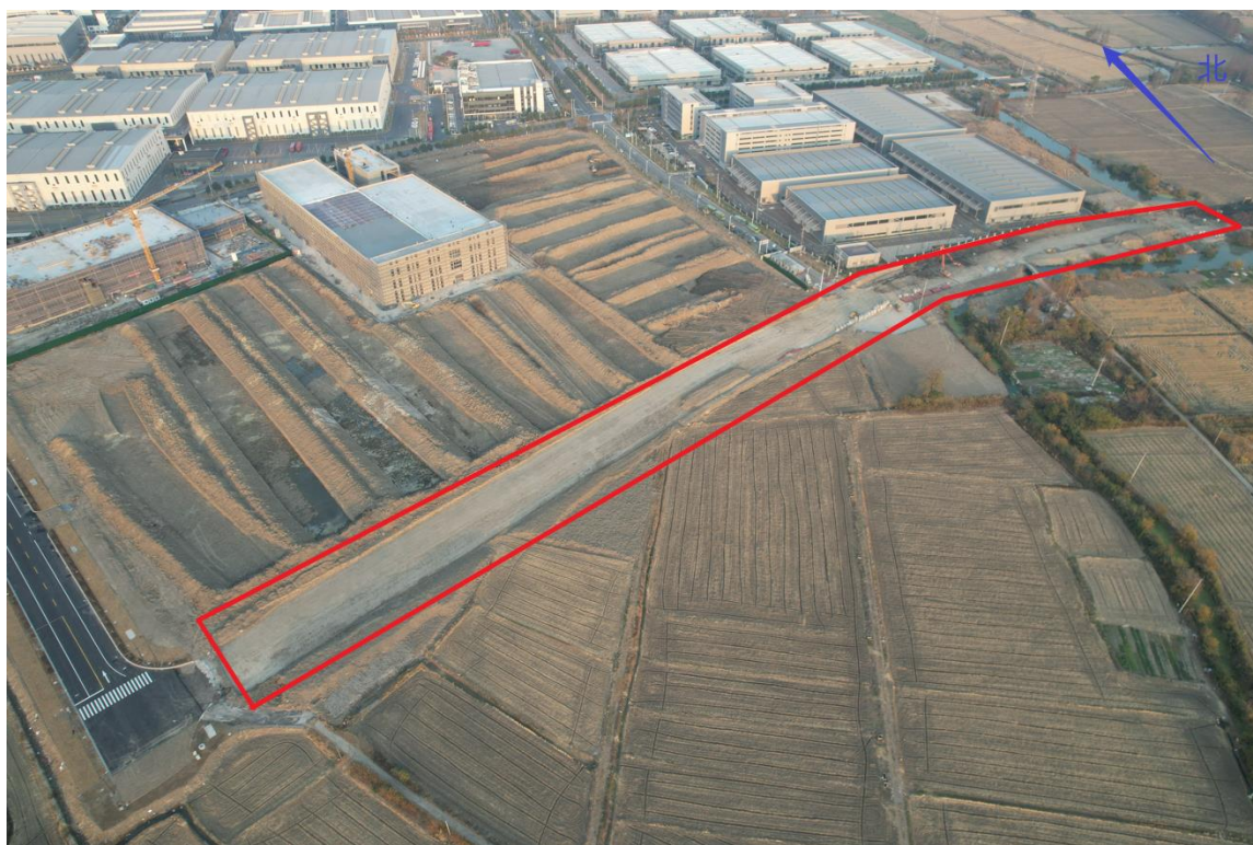
图3.2-2 余方场地现场航拍图（2026年1月）
