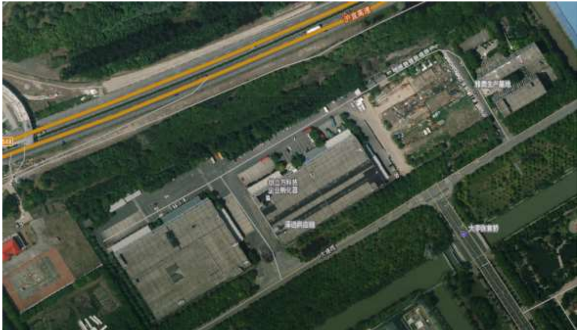
项目所在地拆除前影像图
