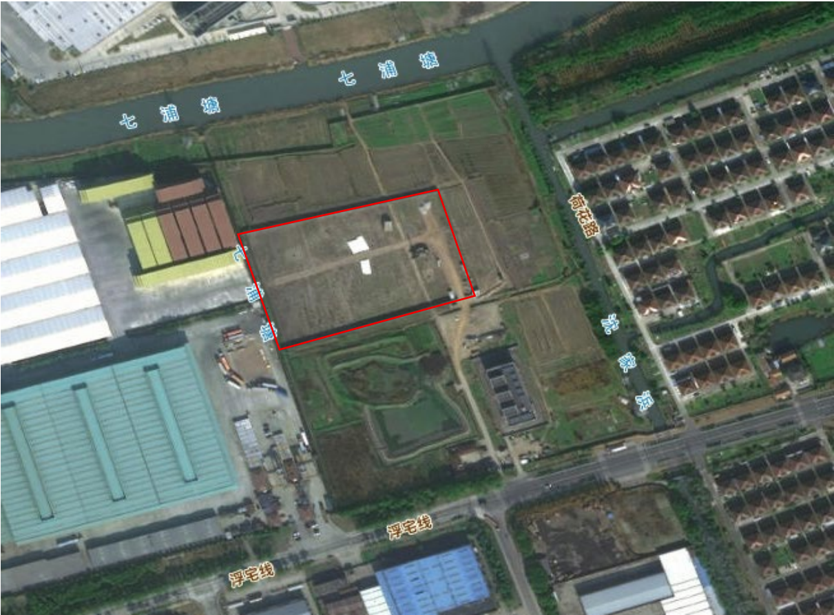
图2-9 场地开工前影像图（2024年12月）
