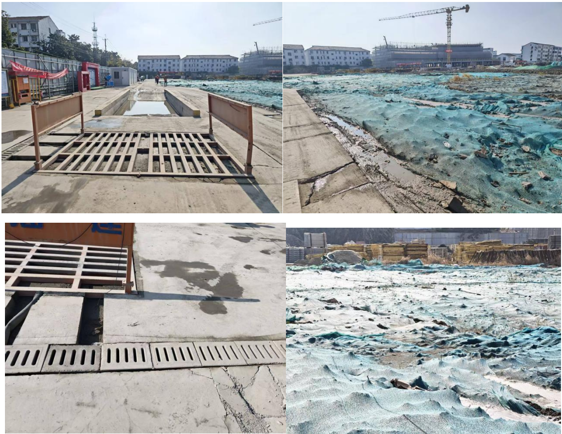
图 3.6-1 施工期间已实施水土保持措施照片
