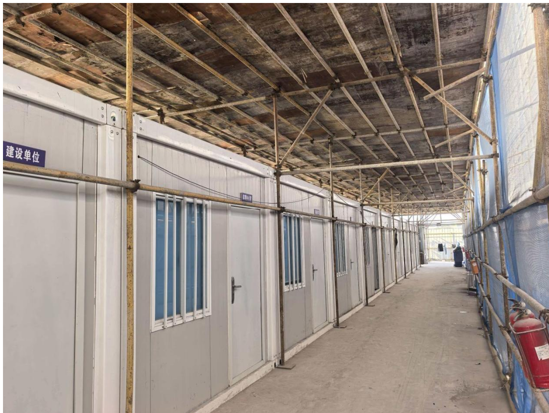
图2.2-2 项目施工办公区
