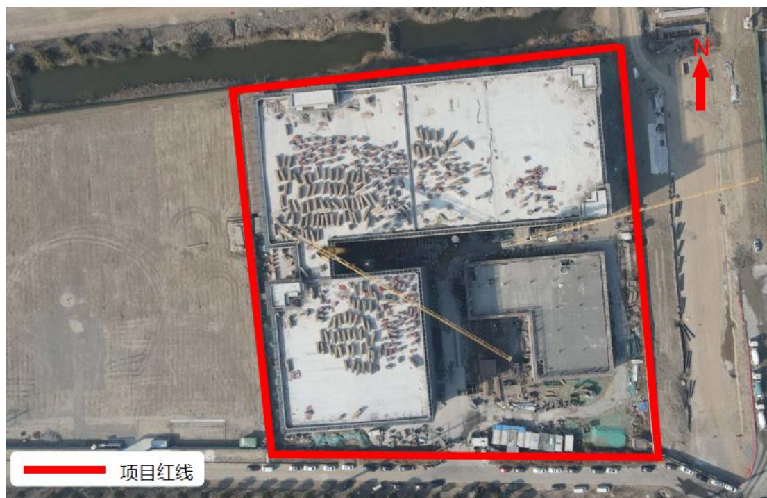
图 2.1-3 项目现状航拍
