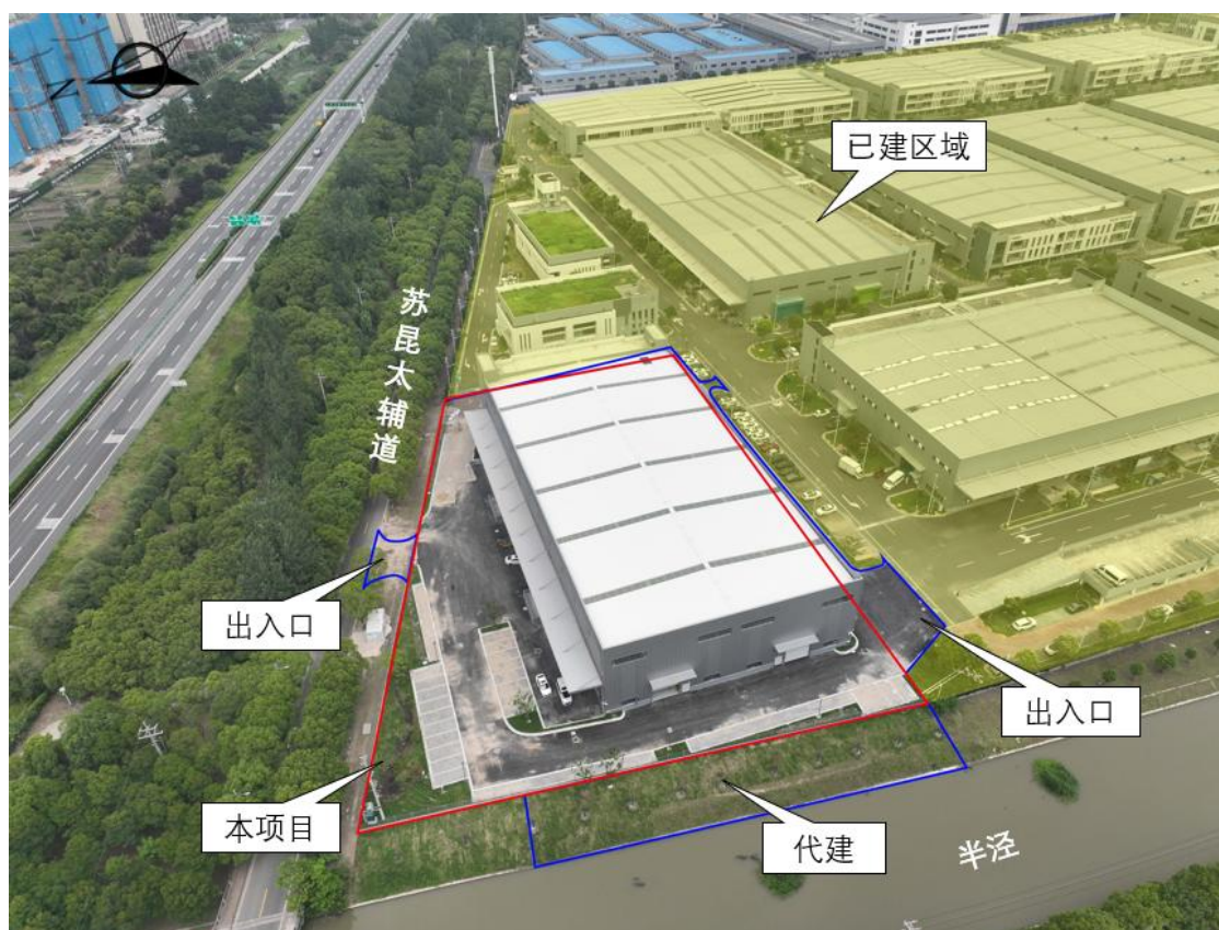
图 2-5 东侧已建区域现状（摄于 2025 年）
